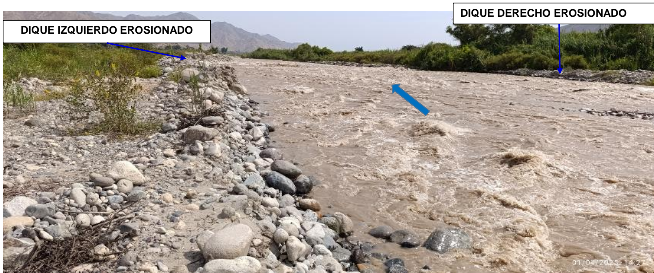
FIGURA N°03: CAUCE DEL RIO CHANCAY-HUARAL, CON EL CAUCE COLMATADO CON FLUJO DE DETRITOS Y CON LOS DIQUES EROSIONADOS POR EL CAUDAL, TRAMO DE RIO CON RIESGO A DESBORDES HACIA AMBOS LADOS.
