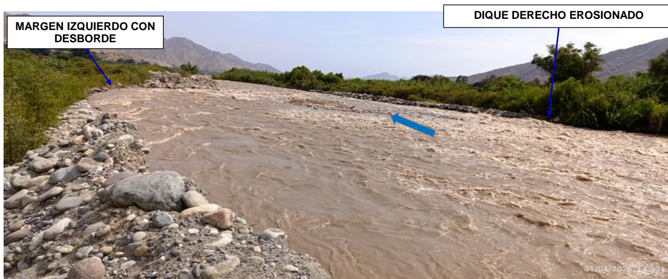
FIGURA N°04: CAUCE DEL RIO CHANCAY-HUARAL, CON EL CAUCE COLMATADO CON FLUJO DE DETRITOS Y CON LOS DIQUES EROSIONADOS POR EL CAUDAL, QUEDANDO MUY DEBIL EL BORDO Y EN LA MARGEN IZQUIERDA CON DESBORDES EN VARIOS PUNTOS
