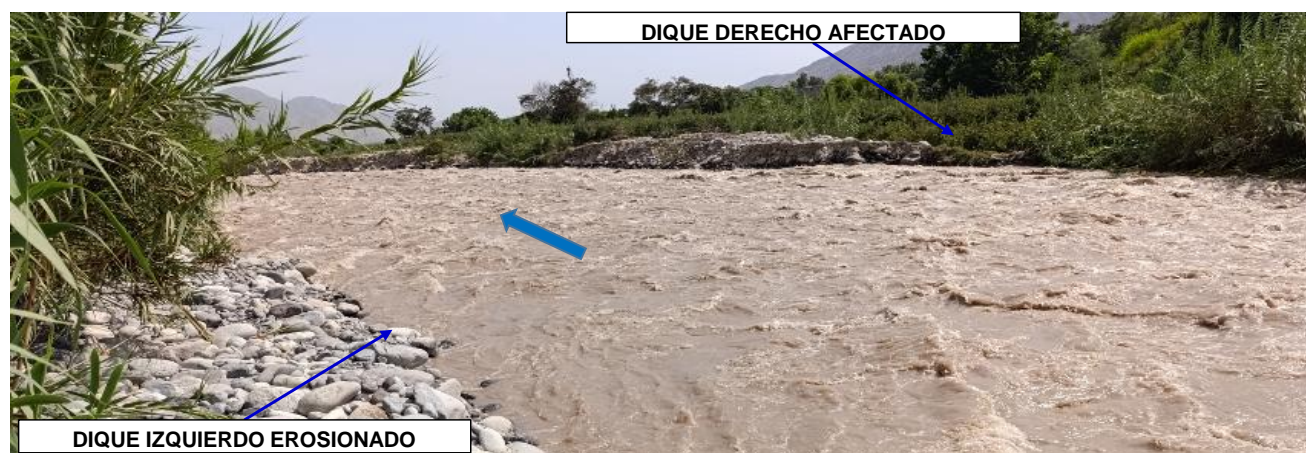
FIGURA N°02: MARGEN DERECHA DEL RIO CHANCAY-HUARAL, AGUA ARRIBA DE PUENTE COLGANTE DE SAUME, CON EL DIQUE EROSIONADO POR EL CAUDAL, PONIENDO VULNERABLE A POSIBLE DESBORDE QUE AFECTARIA AREAS DE CULTIVO DE FRUTALES
